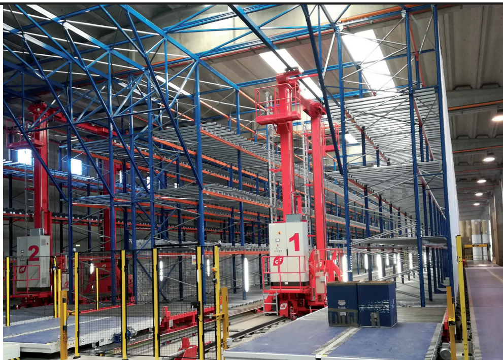
Sistema de almacenamiento automático.
